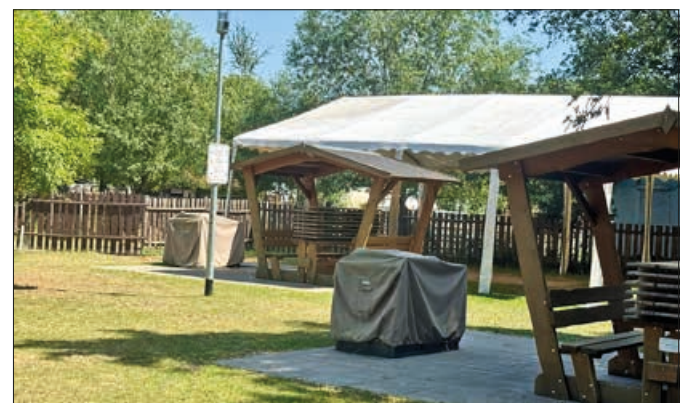
Die Elektrogrillanlagen sollen reepariert werden.
