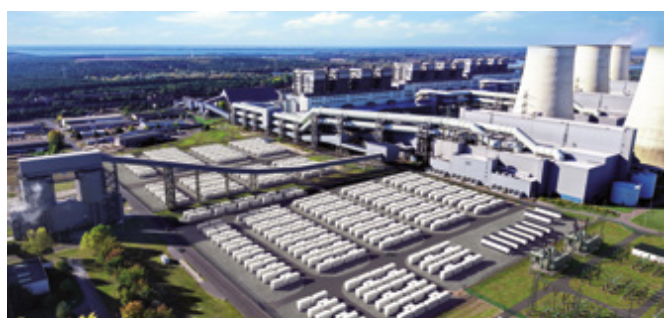
LEAG GigawattFactory Jänschwalde bekommt ersten Giga-Batteriespeicher mit 4.000 MWh Speicherkapazität
