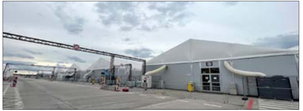
Die Leichtbauhallen am ehemaligen Flughafen Tegel werden nach und nach abgebaut und durch Container ersetzt. Foto: fle
