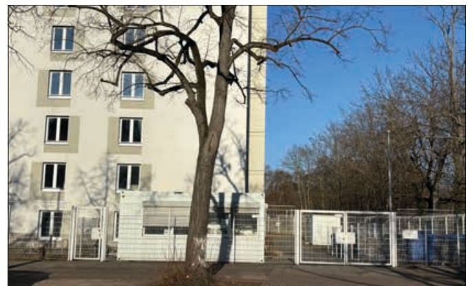
Das Haus Bernauer Straße 138a steht nur vorübergehend leer. Bald beginnen die Sanierungsarbeiten.
