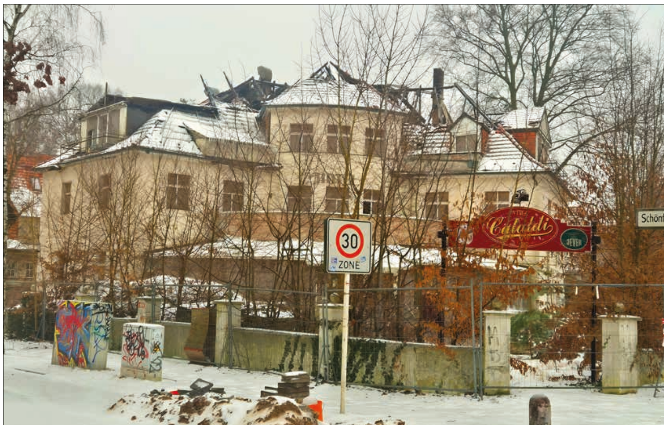
Der Entenkeller nach dem Brand: Vom Dachstuhl ist nur noch das Gerippe übrig.
