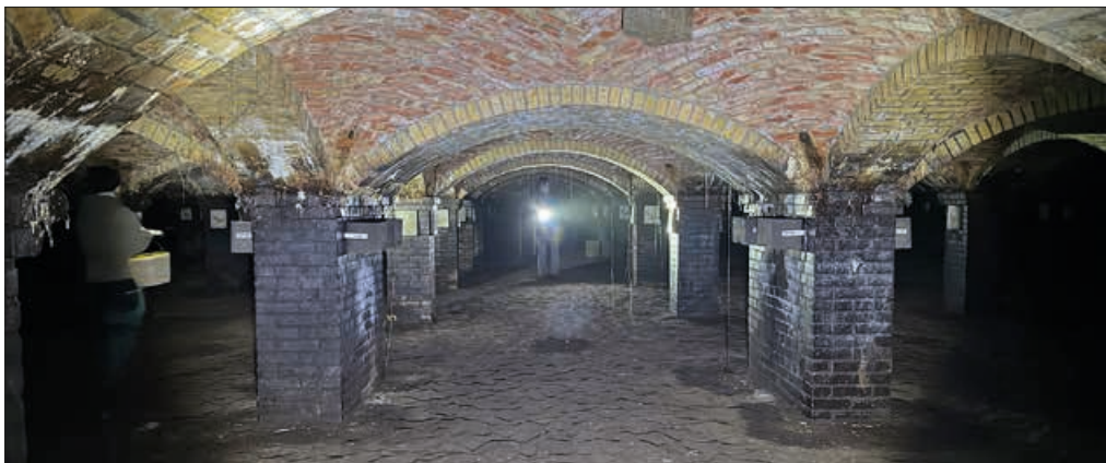
Die beiden unterirdischen Sandfilter-Gebäude sind ein beliebtes Winterquartier. Foto: fle
