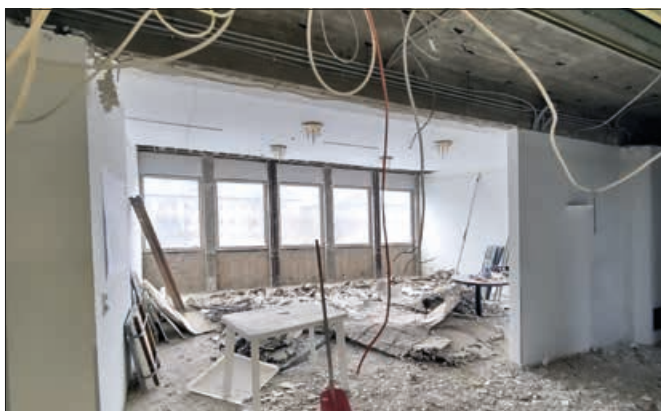
Blick auf die Baustelle im Centre Français
