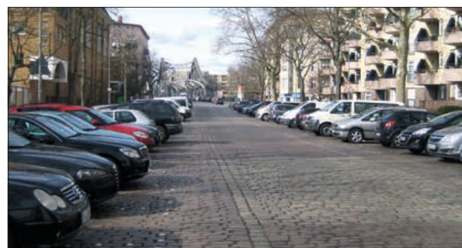
Der nördliche Teil der Swinemünder Straße, direkt vor der Brücke, soll umgebaut werden. Foto: dh
