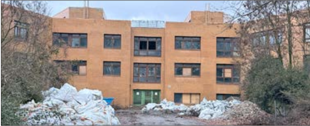
Eines der beiden Sternhäuser, das bald abgerissen wird.
