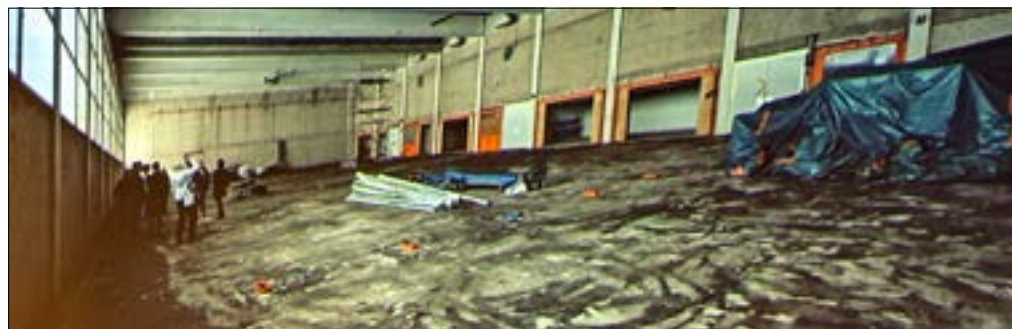
Die Turnhalle der Schule ist seit einem Jahr eine Baustelle.
