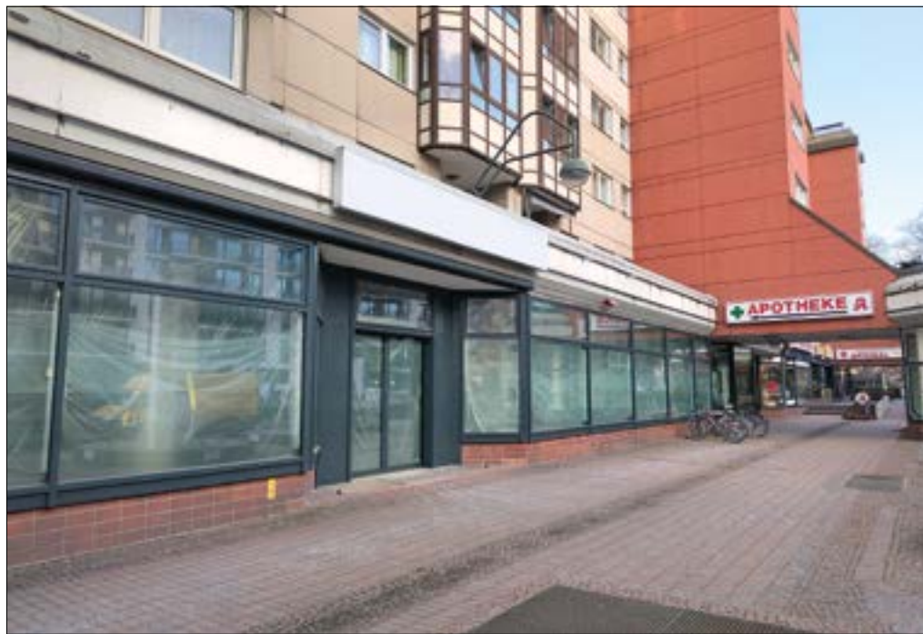
Hinter den Folien im Fenster in der Brunnenstraße 64 entsteht eine Rossmann-Filiale.
