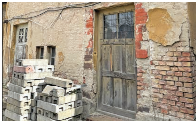
Der Eingang zur Remise. Inzwischen ist er hinter einem Gerüst verschwunden. Foto: fle
