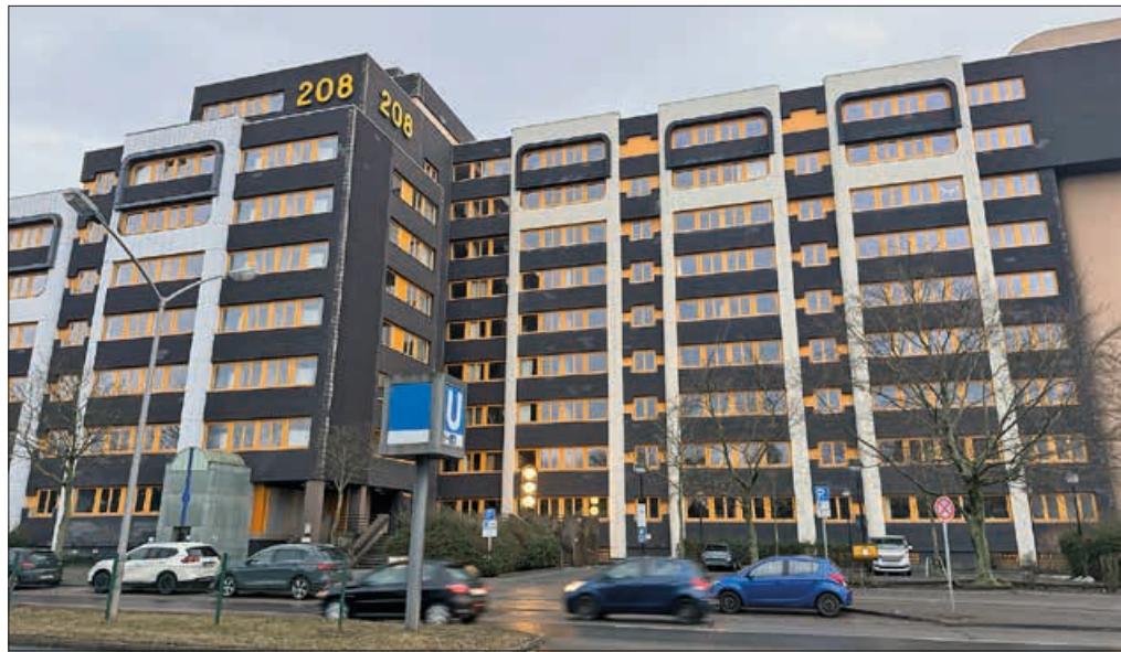
Das Finanzamt am Eichborndamm 208 muss saniert werden.
