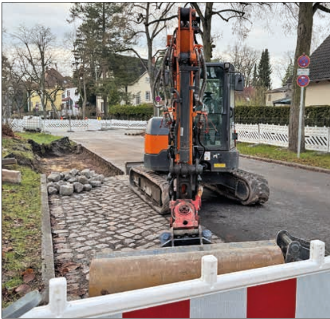
Zwei Jahre dauern die Arbeiten an der Schildower Straße schon. Foto: fle
