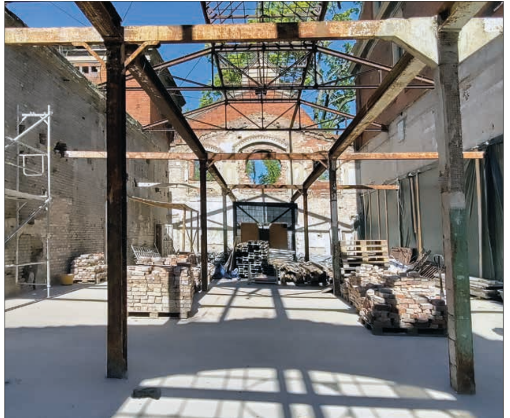
Blick in die Wiesenburg-Ruine. Hier beginnt im Herbst die denkmalgerechte Sanierung und der Umbau. Foto: dh
