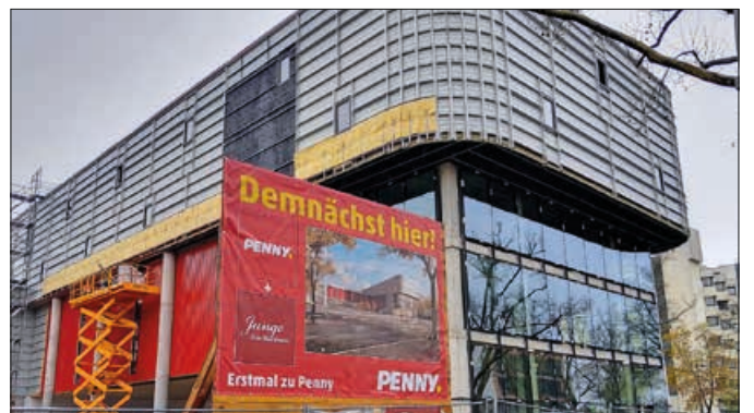
An der Roedernallee entsteht ein Neubau.
