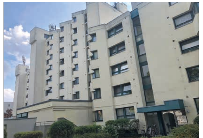
Dieser Gebäude-Komplex mit 174 Wohnungen wird voraussichtlich ab Frühjahr 2027 saniert.
