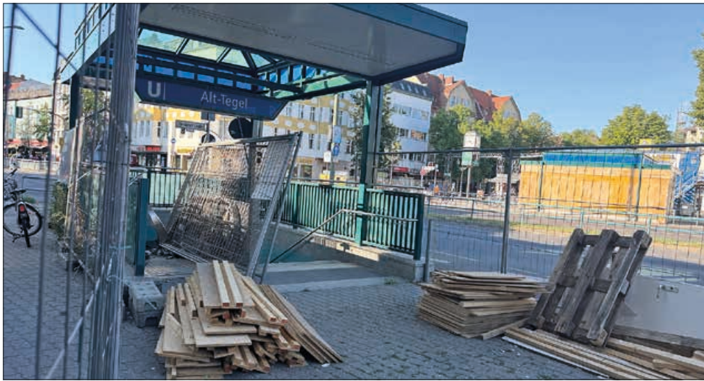
Bauarbeiten wie hier am U-Bahnhof Tegel gehören an der U6 schon lange zur Normalität.
