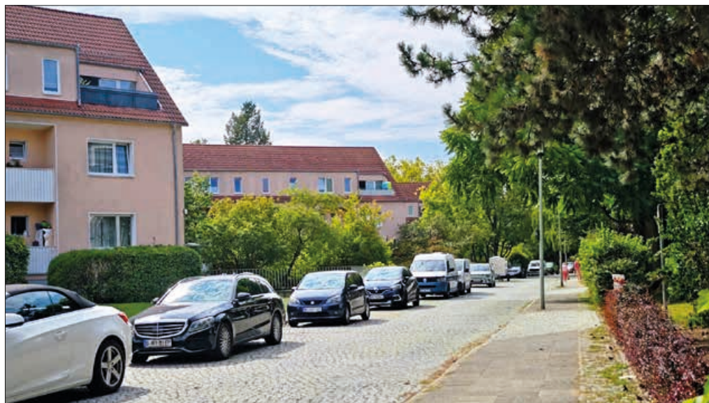
13 Wohnhäuser mit 199 Wohnungen sollen in der Cité Guynemer saniert werden.
