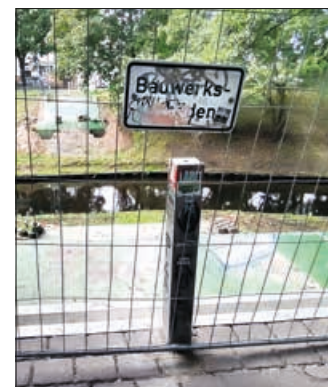
Kein Übergang über die Panke: Die Heubuder Brücke wurde abgerissen. Foto: dh
