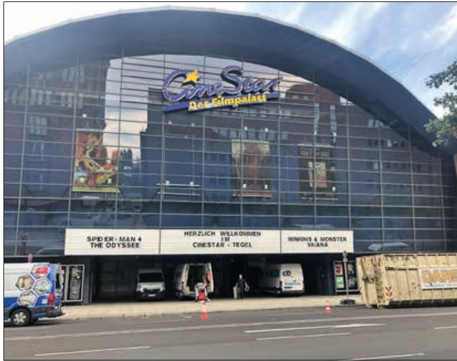
Die Bauarbeiten sind im vollen Gange.
