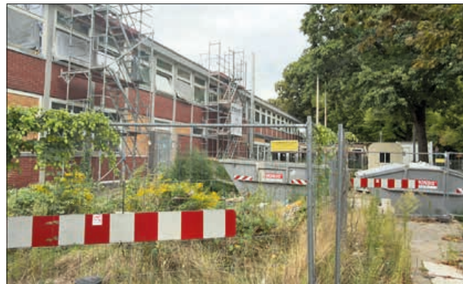
Erbärmlicher Dauer-Zustand: Bibliothek am Schäfersee.
